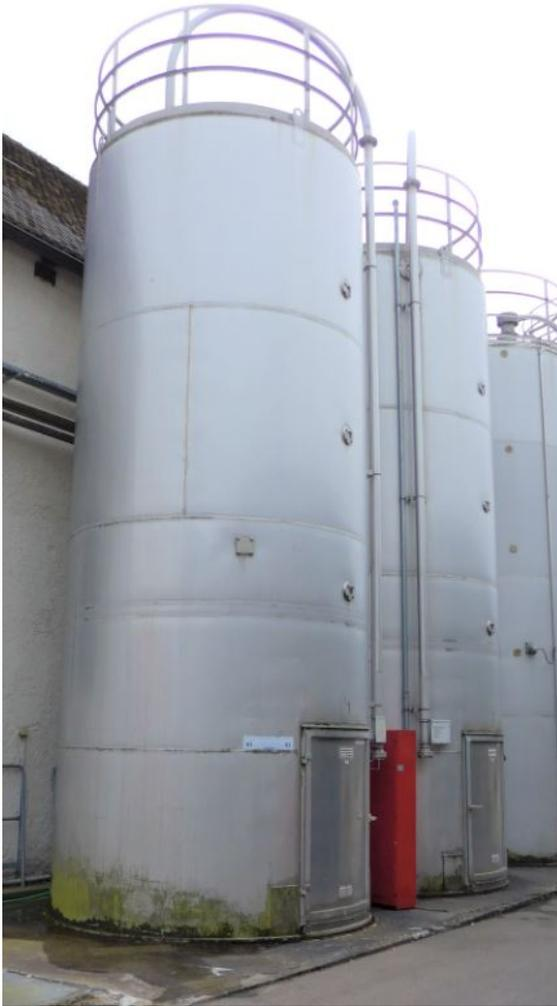
Silo 36.000 Liter aus V2A besteht aus dem Material 1.4301(AISI304) V2A. Das Volumen beträgt ca. 36.000 Liter.
